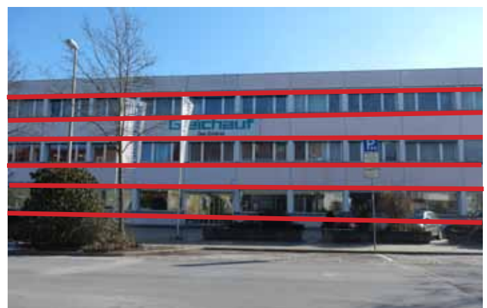
Monotone Fassadengliederung - Bahnhofstraße 23
