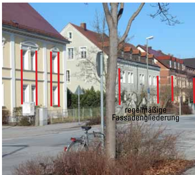
Typische Fassadengestaltung / -gliederung Bahnhofstraße
