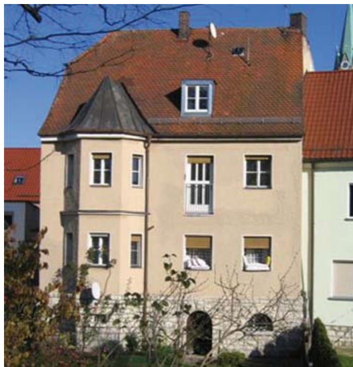
Das Planungskonzept für das Jugendstilhaus am Rainbügl beinhaltet sowohl eine stilgerechte als auch energetisch hochwertige Sanierung.
