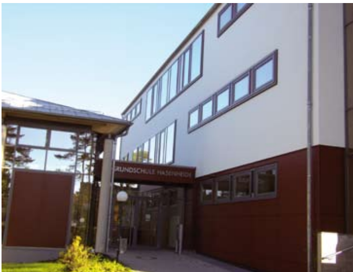
Durch umfassende Sanierungsmaßnahmen werden in der Grundschule Hasenheide rund 50 % Energie eingespart.
