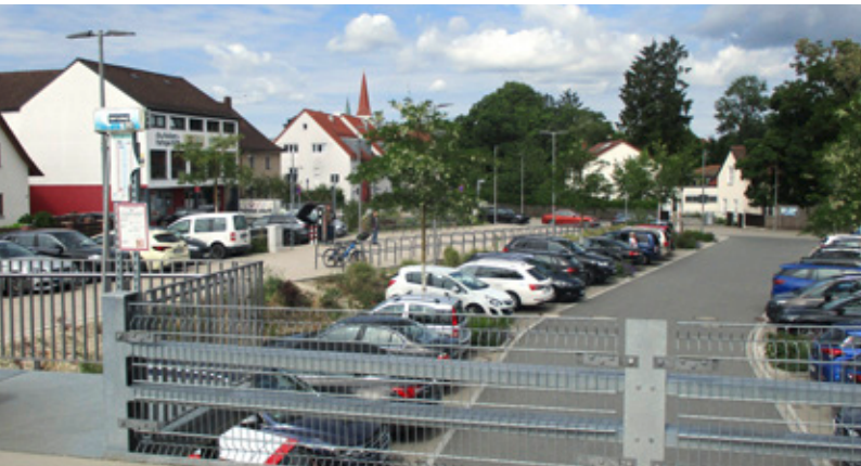
Abb. 11: Das Regenrückhaltebecken Ecke Seelstraße und Sandstraße im Bau und nach seiner Fertigstellung (Quelle Bild rechts: PETTER INGENIEURE GmbH; Quelle Bild links: Werner Schütt/Stadt Neumarkt 2025)
