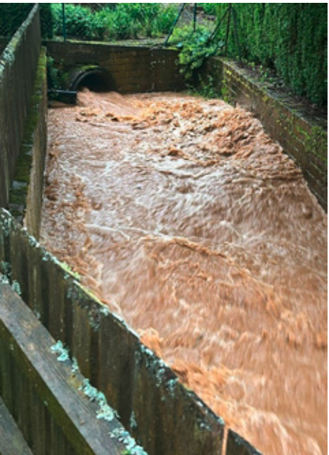
Abb. 19: Durch Starkregen überlastete Verrohrung (Quelle: Daniel Gottschalk/Stadt Neumarkt 2024)
