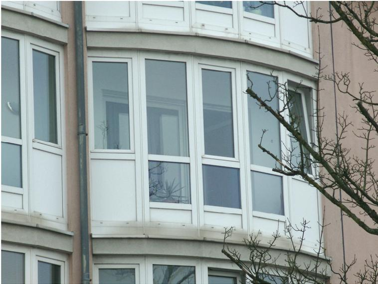
Abbildung 12: Schalltechnische Optimierung durch Wintergartenvorbauten (hier: Ambergerstraße)
